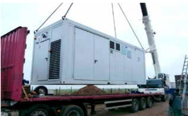
b) Gasificador de madera + equipo pre-ensablado para edificio existentes
